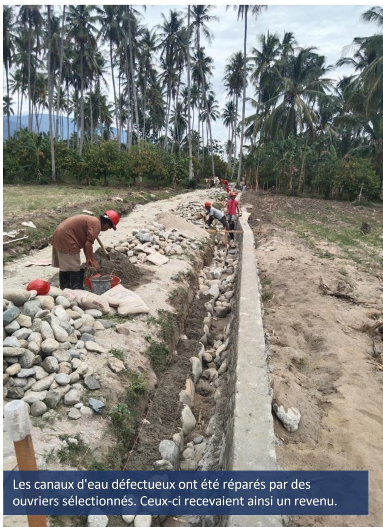
Les canaux d'eau défectueux ont été réparés par des ouvriers sélectionnés. Ceux-ci recevaient ainsi un revenu.
