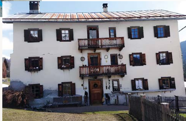
Der „Hitzenboden“ vorher und während der Aussenrenovation.
