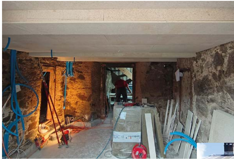
Der Keller wird feuerfest isoliert und mit einer neuen Elektrik versehen.
