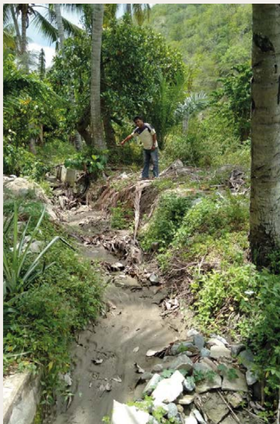
Bewässerungskanal direkt nach der Katastrophe 2018.
